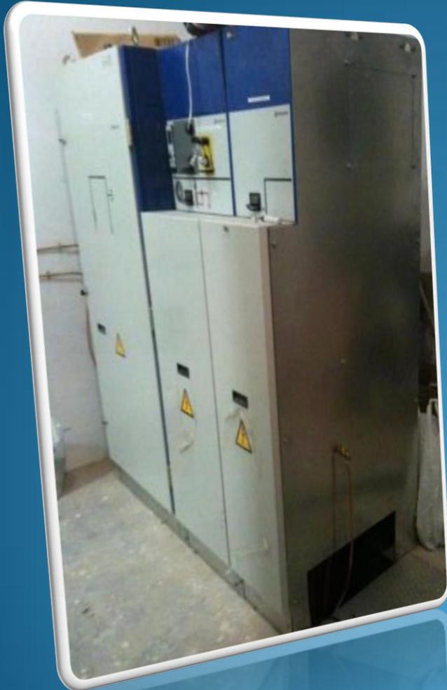
La urgente necesidad de renovar toda la instalación eléctrica del edificio, hacía inaplazable la adecuación de la potencia suministrada al edificio, con la demanda energética real, que resultaba muy superior a la potencia contratada. Esta solución pasaba por implantar un Centro de Transformación exclusivo para la sede del Ateneo, que se alimenta de la red eléctrica de media tensión permitiendo cubrir las necesidades energéticas del edificio y una sustancial reducción de los costes eléctricos.
