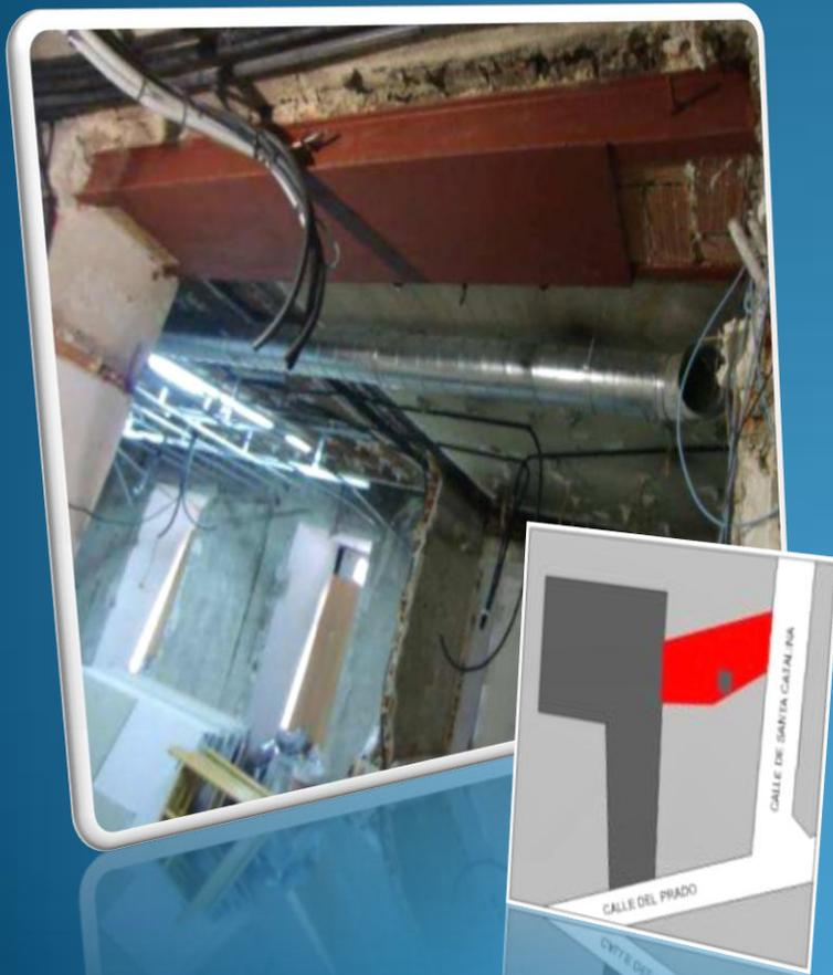
Se han realizado actuaciones de consolidación y refuerzo estructural en las plantas sótano, baja, primera y segunda del edificio de Santa Catalina 10. Aprovechando que se actuaba en el acondicionamiento de estas plantas, se han realizados catas y análisis de diferentes elementos estructurales y se han observado importantes deficiencias de carácter muy grave en el caso de algunas vigas cargadero ejecutadas en las reformas que se sucedieron en el edificio a mitad del siglo pasado.
