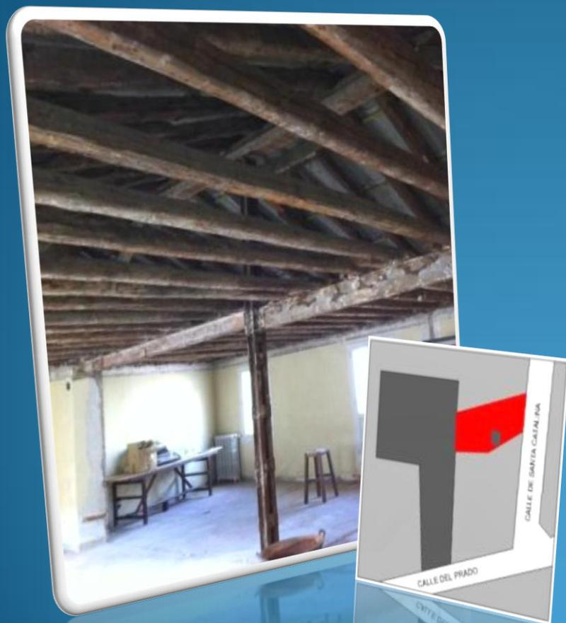
Actuando de urgencia debido al precario estado de conservación que presentaban los falsos techos de la zona derecha de la planta quinta del edificio de Santa Catalina, se procedió a realizar una demolición de estos falsos techos, que además ha permitido observar con claridad el estado de la estructura de la cubierta, así como del tablero y tejas de cubrición, descubriendo ciertos desperfectos y deficiencias. Se han levantado también los solados de linóleo que presentaban zonas abombadas.
